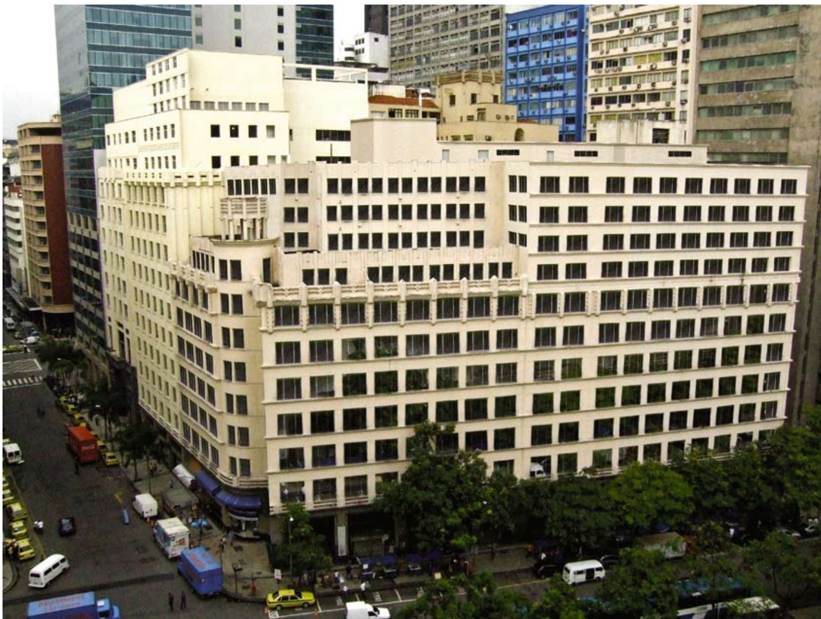
Edifício Castelo • Depois
